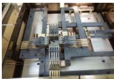
延伸前 (槽内セット時)
